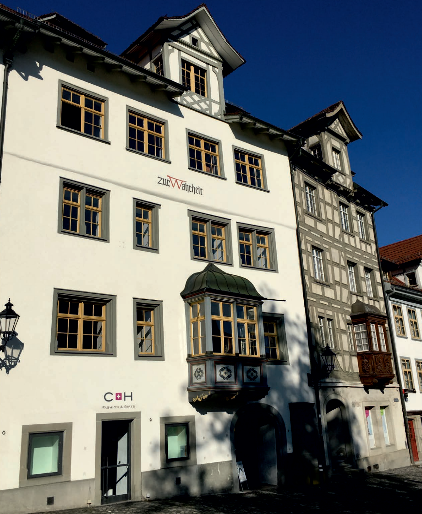
Hauptstandort in St. Gallen / Haus zur Wahrheit
